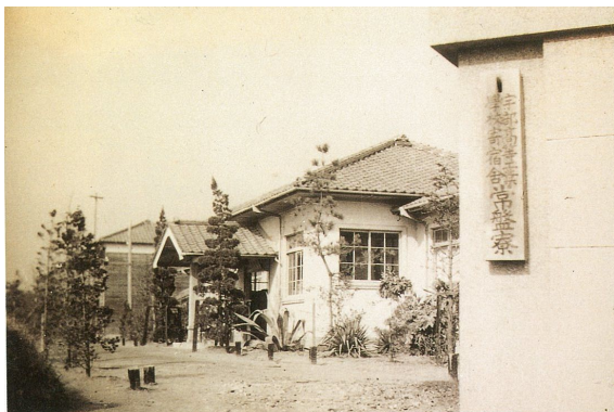
完成した常盤寮(1・2・3寮)
