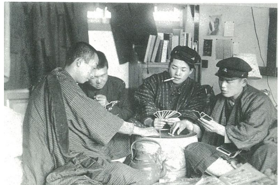
トランプをする寮生(鶉之島寮で)
